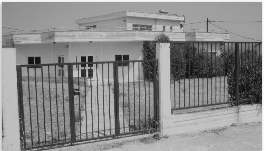
Κτήριο παιδικού σταθμού
